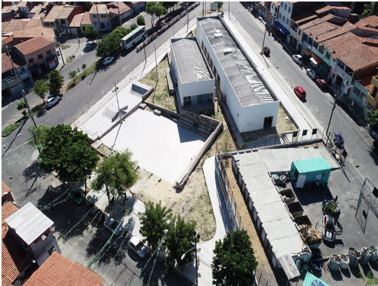
Imagem 01 – Foto geral dos blocos
